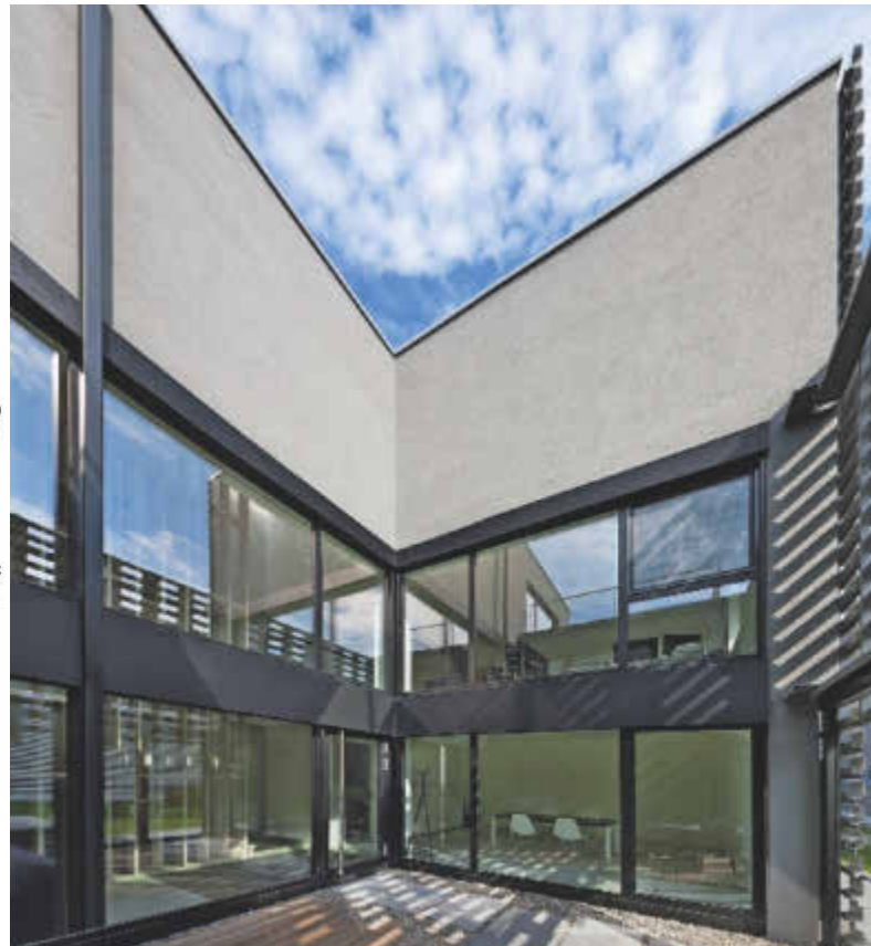
Verglasteter eingeschnittener Lichtthof.
